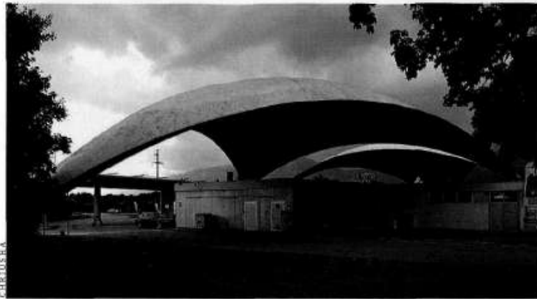
Megaschale ohne herkömmliche Bewehrung: Raststätte Deitingen an der A1 Zürich-Bern.
