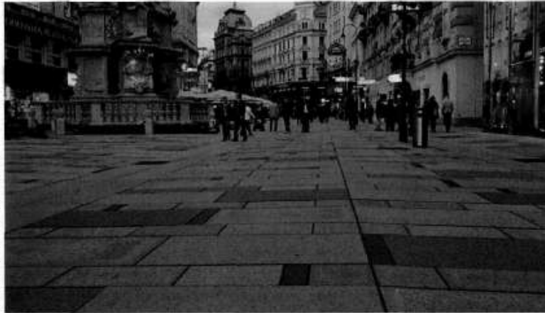
Pflasterdrainbeton als innovative Lösung für Pflastersteinstraßen wie den Wiener Graben.
